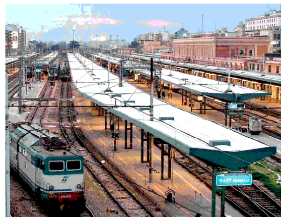
Una veduta della stazione ferroviaria Bari Centrale
